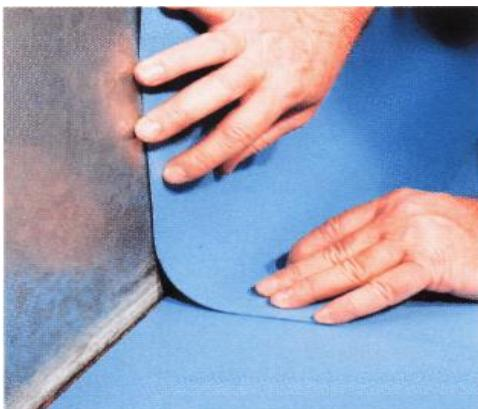
Зафиксируйте мембрану на вертикальные стены, следуя технологии описанной в предыдущих главах. Соблюдайте нахлест стыков и краев пластов 5 см.
